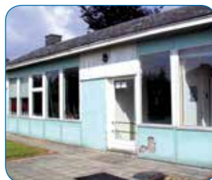
Allèges de fenêtres et revêtement de colonnes en glasal
