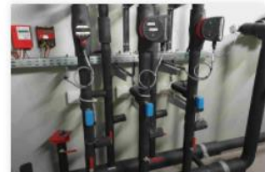
Détection de fuites à l'aide de capteurs intelligents
